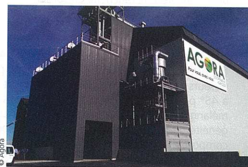
→ Le nouveau bâtiment, implanté en bordure de l'autoroute A1 et de la ligne TGV Nord, soigne son esthétisme avec un bardage bicolore.
