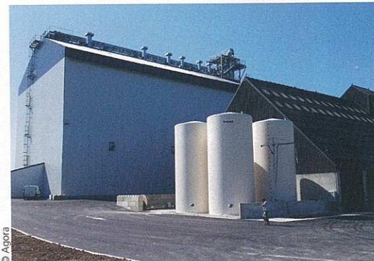
→ Photos d'ensemble du silo, côté cour.
