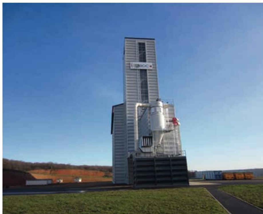
→ Le silo de Luigny se dresse, filiforme, dans la campagne d'Eure-et-Loir.
