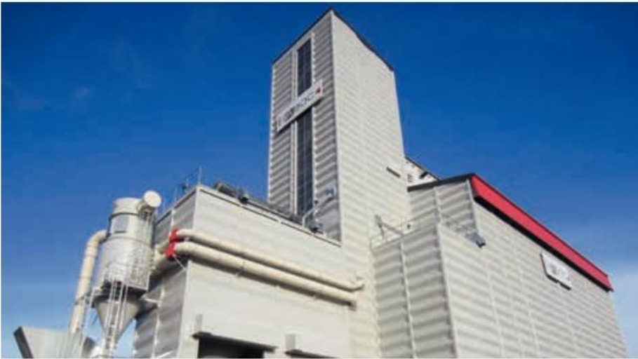
→ La société Saboc a pris l'option d'un silo dont l'enveloppe et les cellules sont construites en palplanches.
