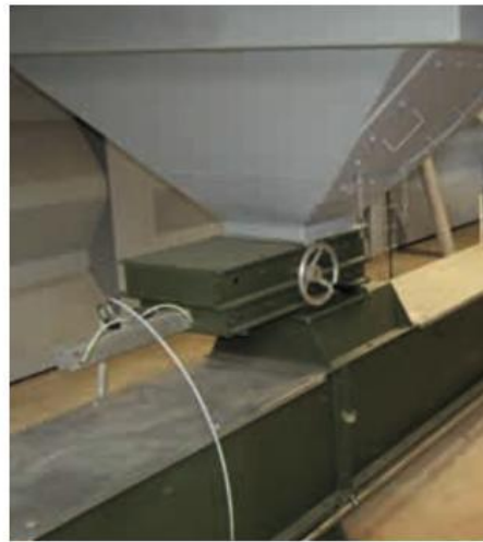
→ Le silo de Belle-Assise est doté d'un outil de travail performant.
