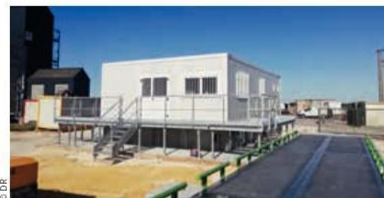
→ Les nouveaux bureaux permettent au chef de site de suivre l'évolution des 24 cellules du silo.
